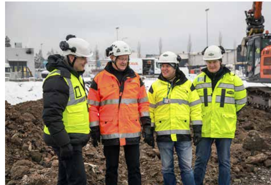
Tomi Lempinen (to the left), Uponor, Tapio Kalliola, EKE-Rakennus, and Tommi Heikkinen and Markku Hurskainen, Hyvinkään Tieluiska are satisfied with the fast and easy installation.
